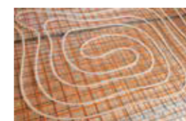
Slučka podlahového vykurovania
